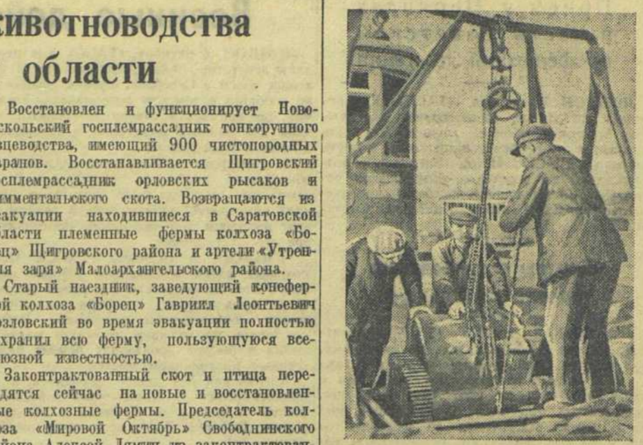
ОРЕЛ СЕГОДНЯ. Рабочие и инженеры Орловского трамвайного парка ведут работы по восстановлению городского трамвая. На снимке: сасари-монтажные производят подвешку и монтаж трамвайных вагонов. Фото Н. Ситникова. (ТАСС).
